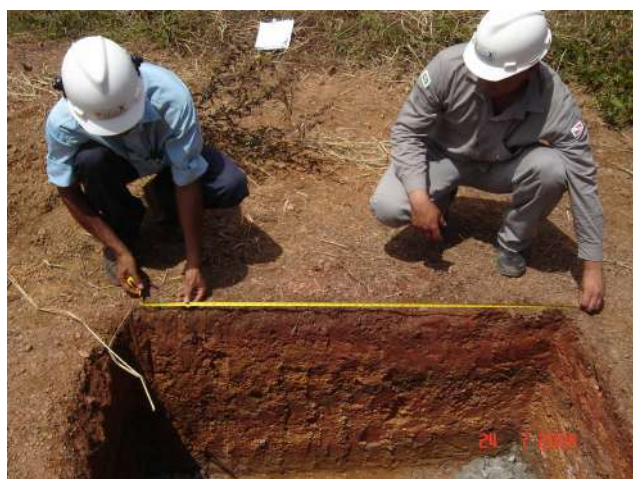
Abertura do buraco conforme dimensões especificadas
