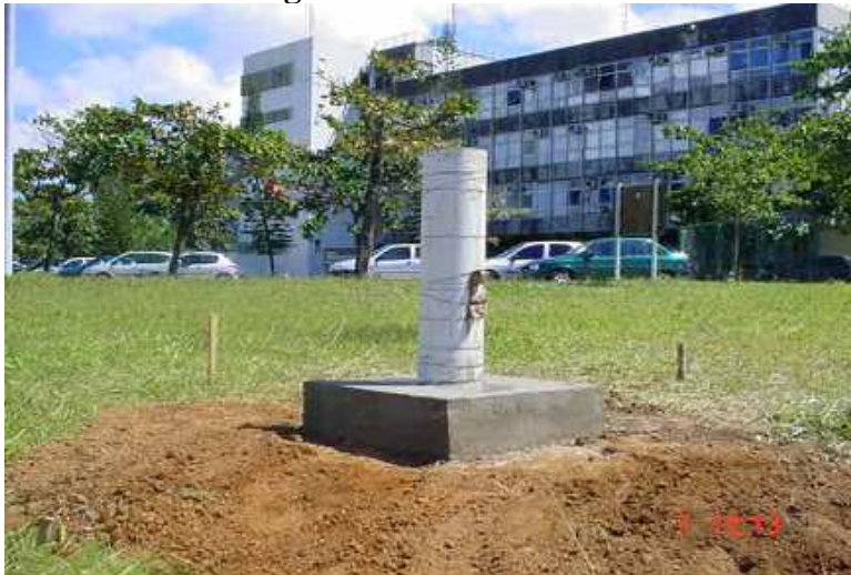
Pilar concretado aguardando a cura
