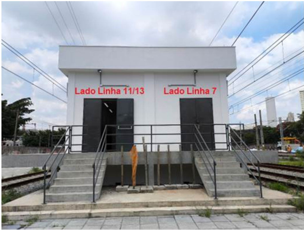
Foto 1: Entrada da sala técnica de sinalização Microlok
