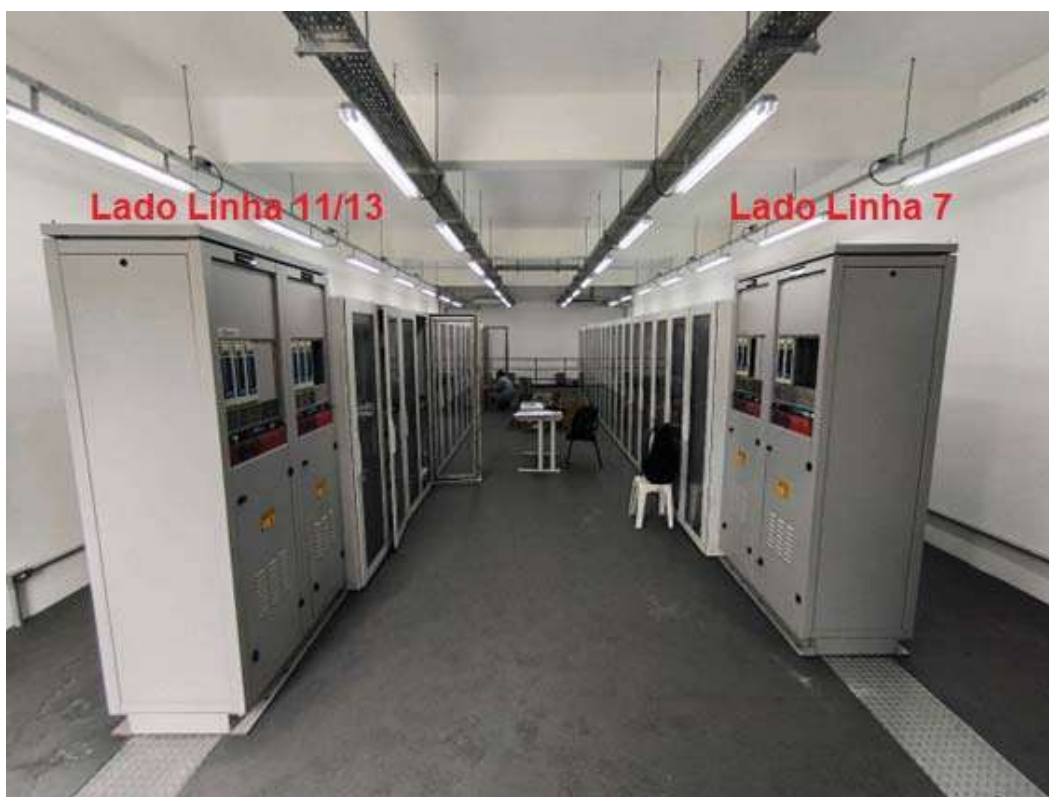
Foto 2: Disposição dos racks do sistema de sinalização Microlok L11/13 e Microlok L7
