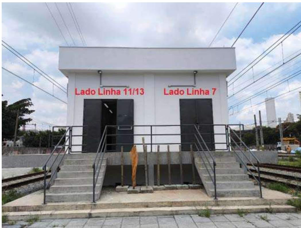
Foto 1: Entrada da sala técnica de sinalização Microlok
